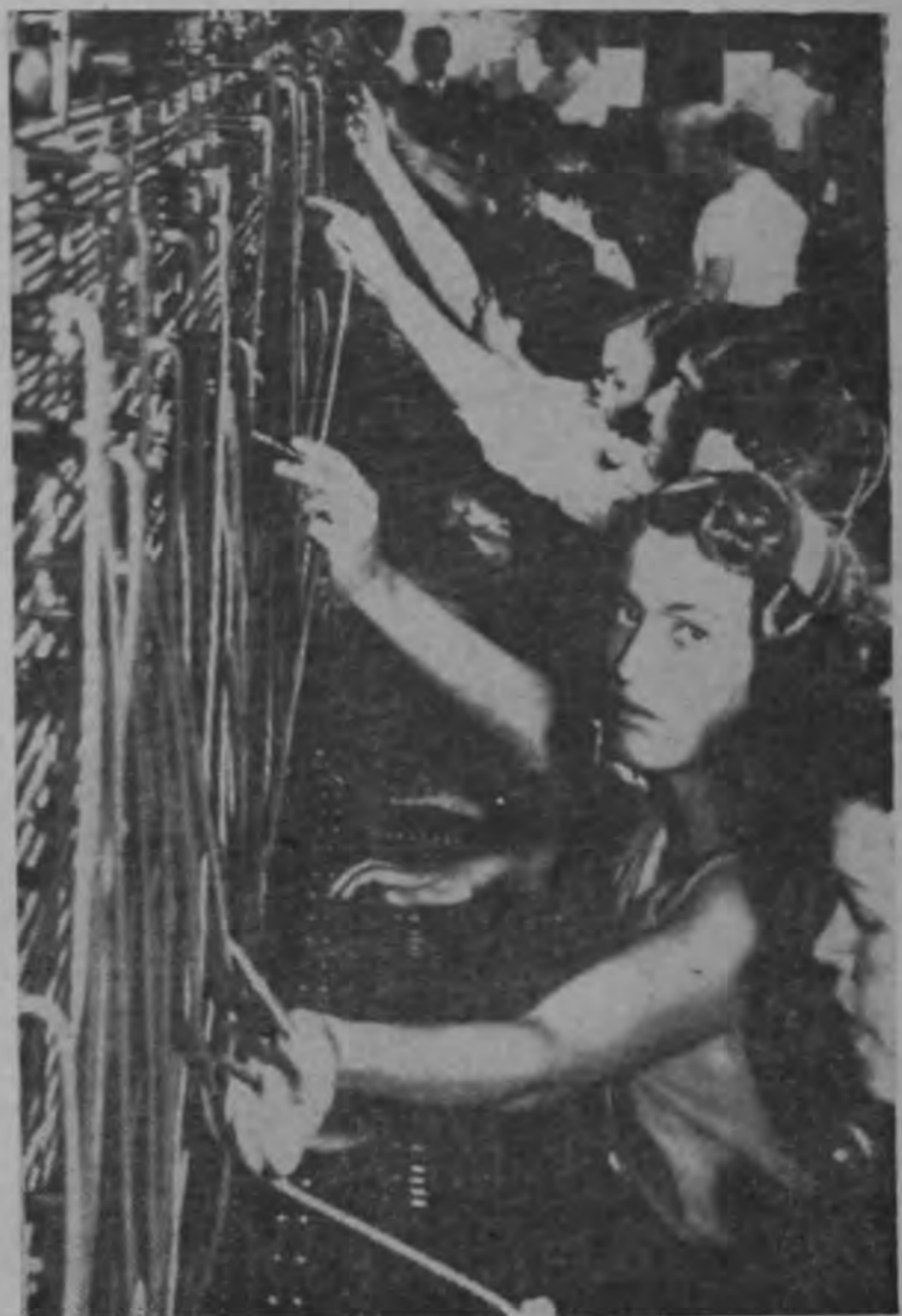
A este tablero convergen 4.315 líneas telefónicas. Hay otro con la misma capacidad. Cada telefonista atiende como promedio diario, 2.500 llamadas. Cada orificio que se observa corresponde a una línea y al hacerse la llamada se enciende un pequeño foco. Durante la noche esto parece el espacio sideral, pero en rojo. Este anticuado sistema de cordones es el causante de muchas deficiencias.
