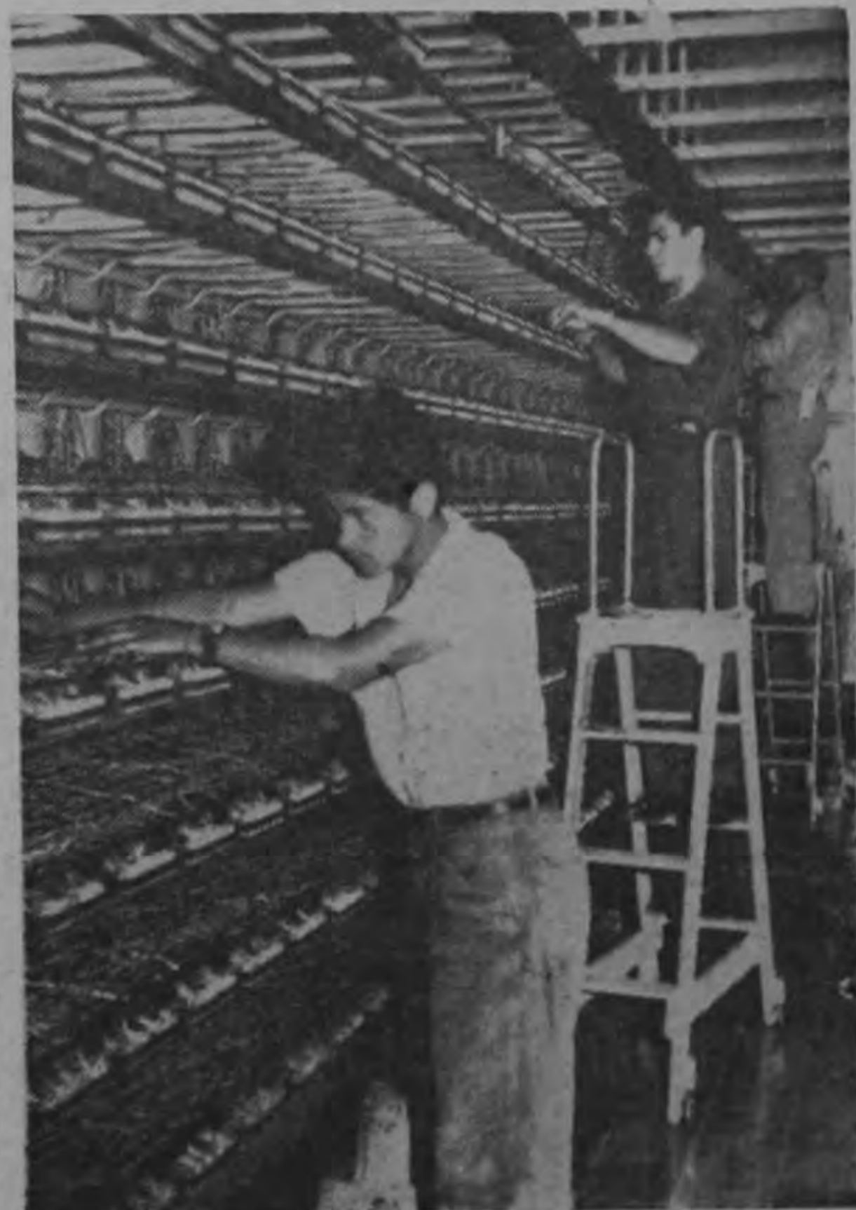
Esta sección corresponde al Departamento de líneas. Es una trama de cientos de miles de alambre, que sólo el ojo experto de los encargados puede determinar donde se produce un daño.
